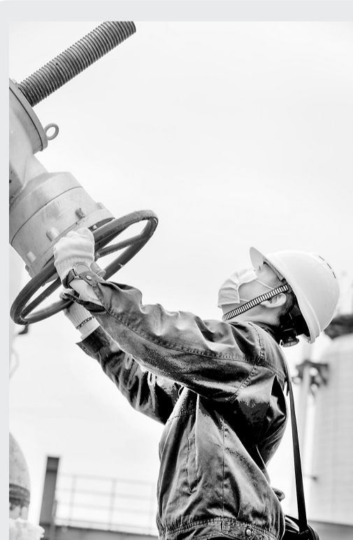
在泉州市惠安县泉惠石化工业园区,中化泉州乙烯项目EPC装置班长刘飞奇正在开DN600手阀,确保装置运行。(文通讯员 黄小红 图/谭朝浩)
